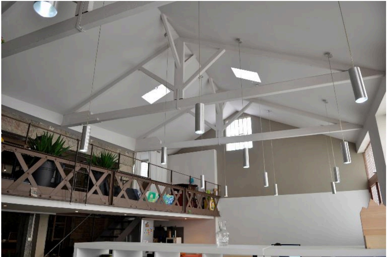
Vue intérieure de l'atelier implanté dans le creux du L
