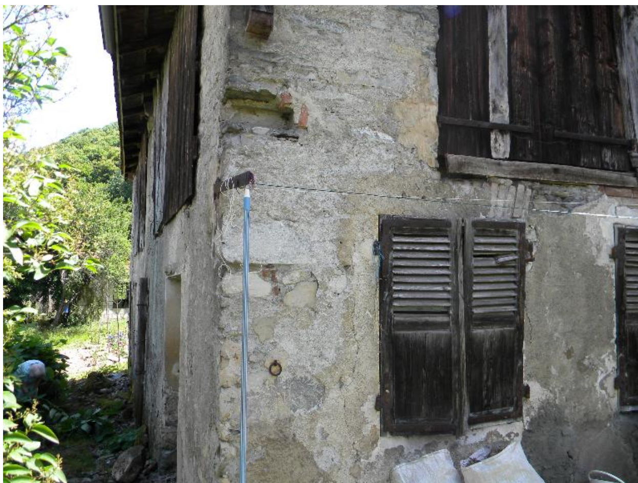
Vue de trois-quarts (façades ouest et nord)
