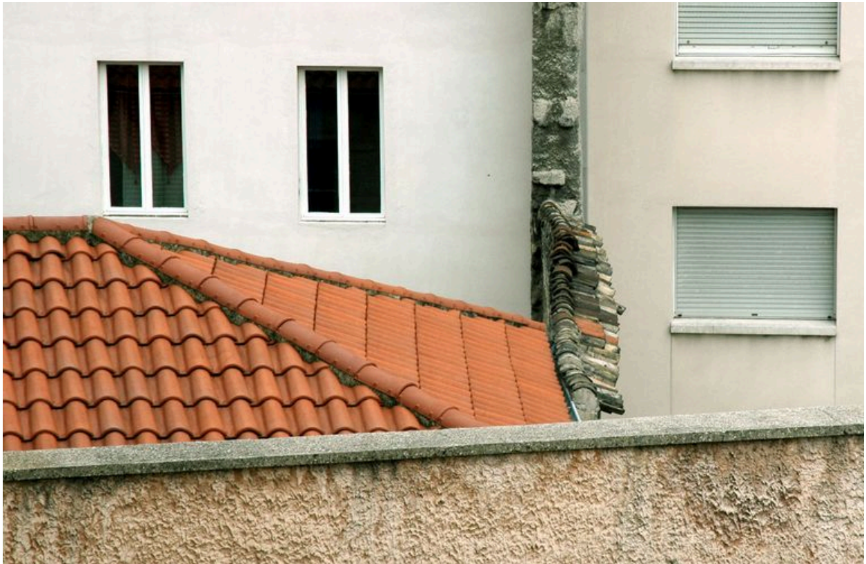
Mur mitoyen entre les parcelles du 110 et 112 Grande rue de la Guillotière vu depuis le sud
