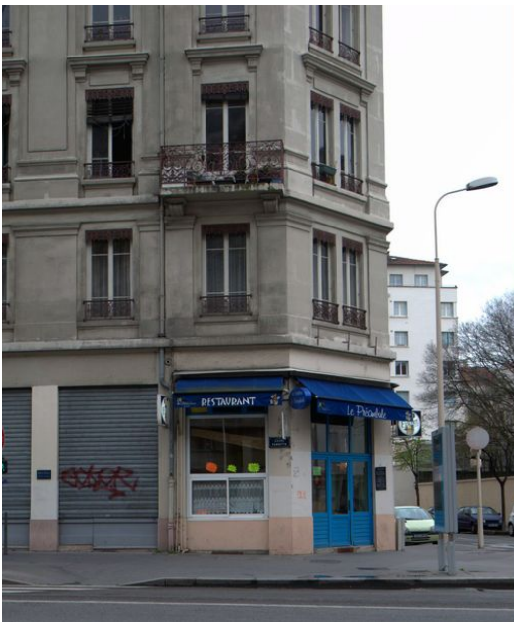
Elévation principale, détail de l'angle
