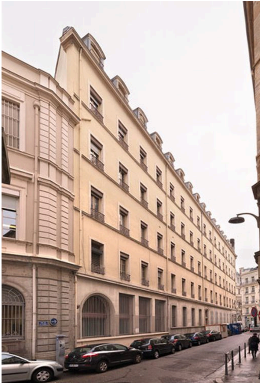
Vue des élévations de la banque et du Grand Hôtel rue de la Gerbe.
