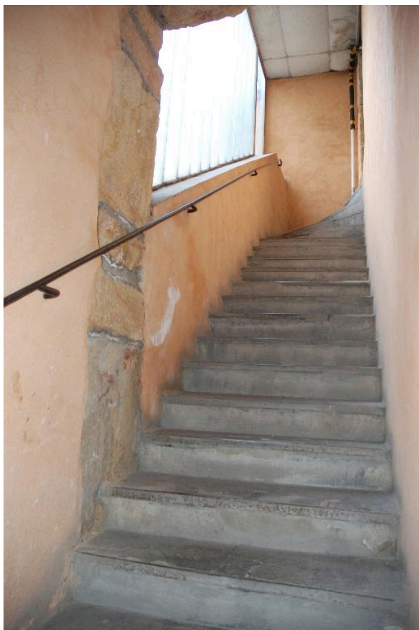
Vue de la première volée de l'escalier
