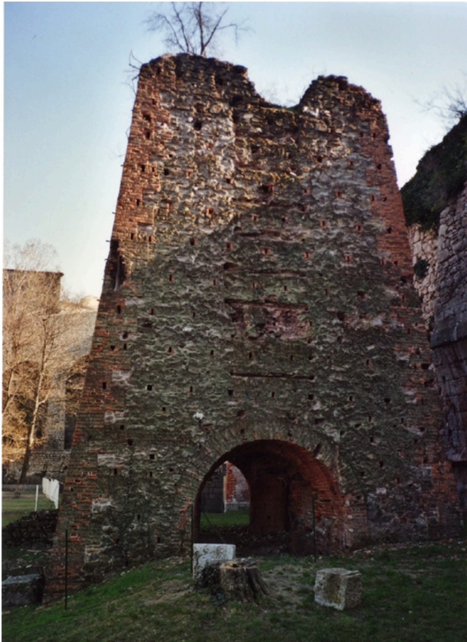
Vue nord d'un haut fourneau
