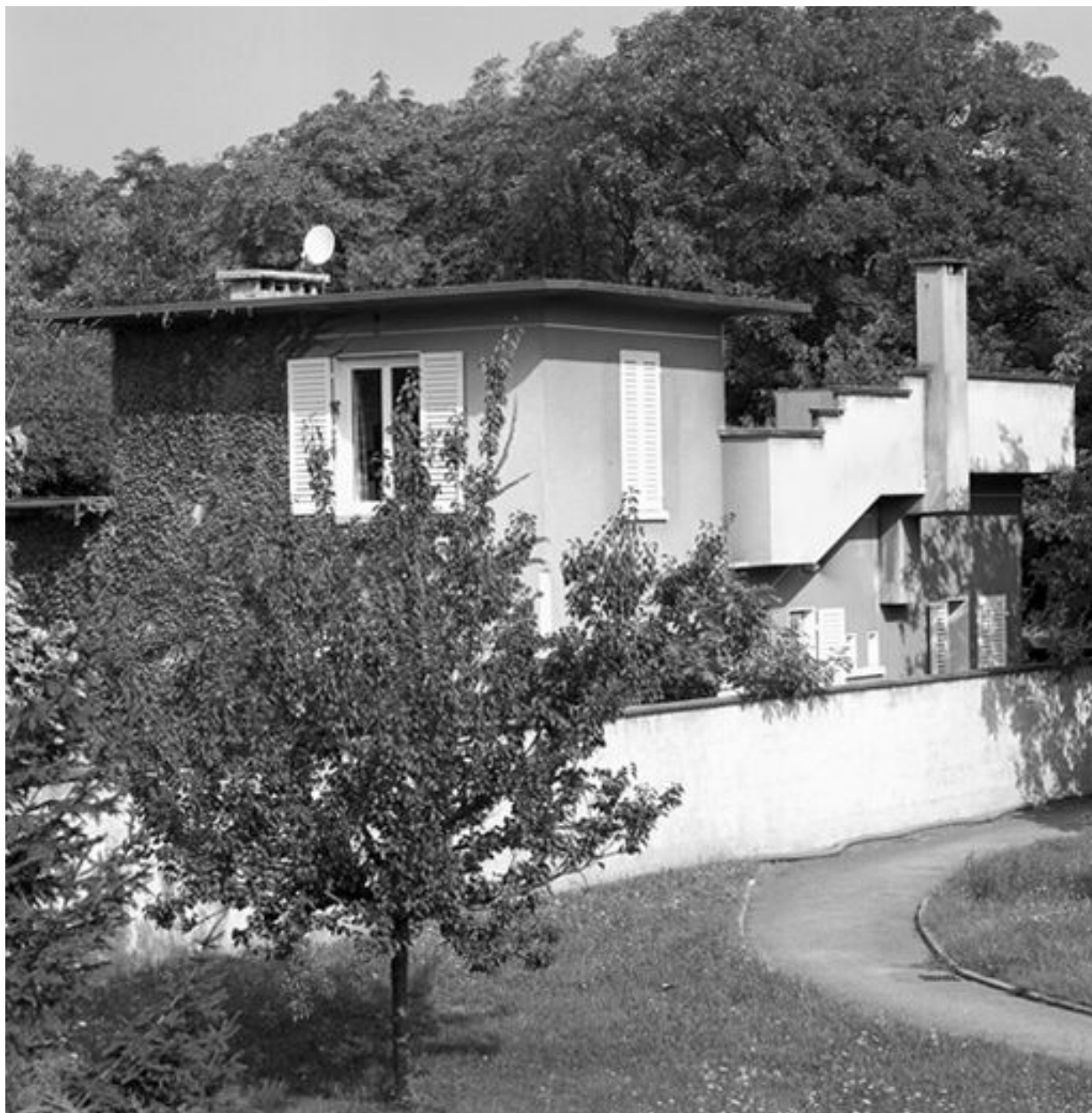
Logis, façades sud et est
