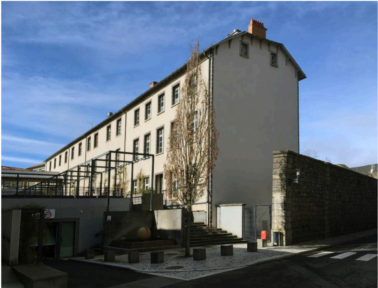
Corps de bâtiment ouest : vue d'ensemble depuis le nord
