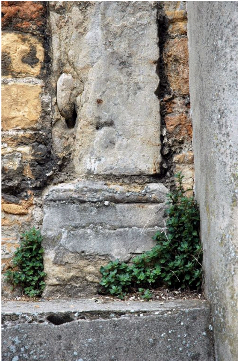
Mur de clôture sud-ouest, ancienne porte des Minimes, détail de l'encadrement
