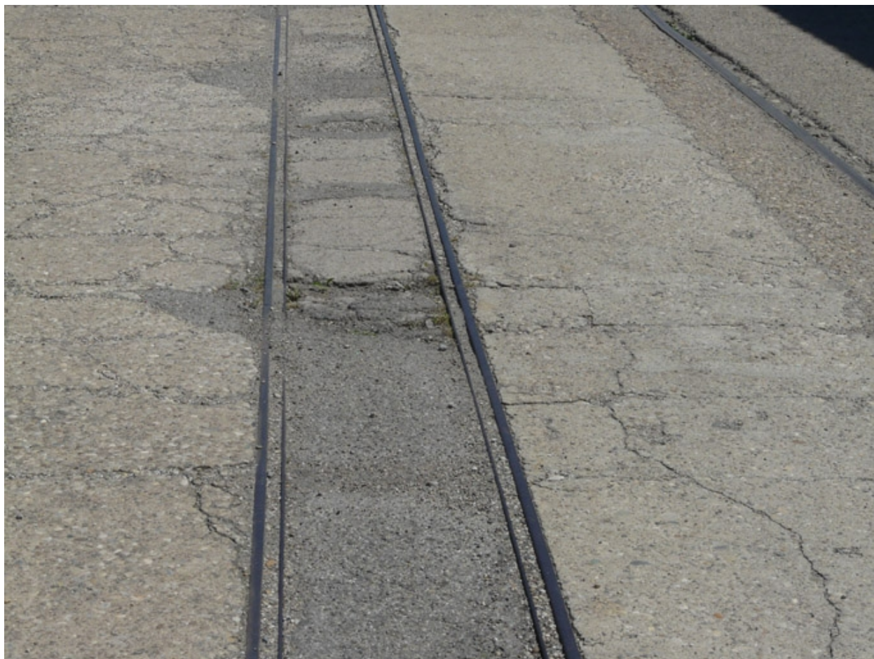
Traces au sol des voies pour la circulation des wagonnets (grande halle)
