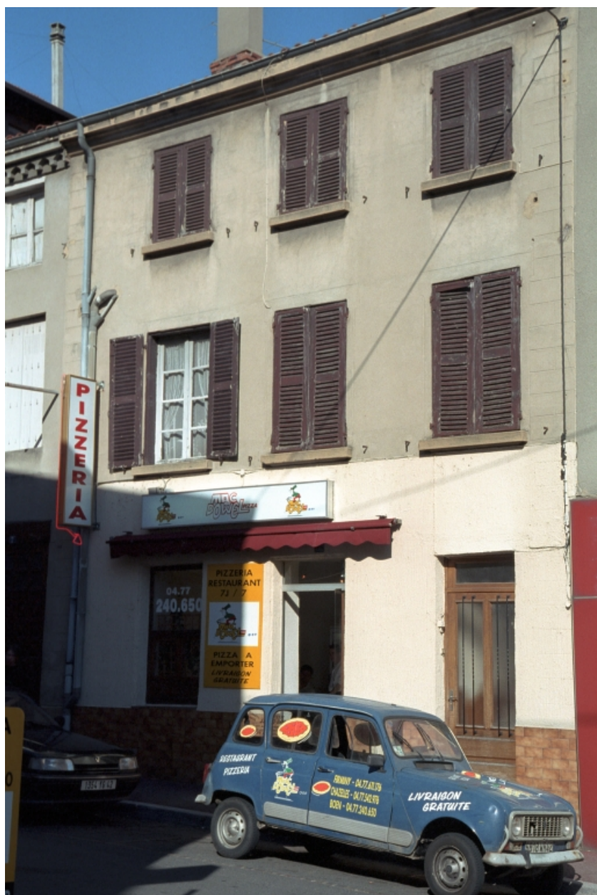
Boën, îlot 18, Saint-Jean (rue) 5. Vue générale de la façade sur rue.
