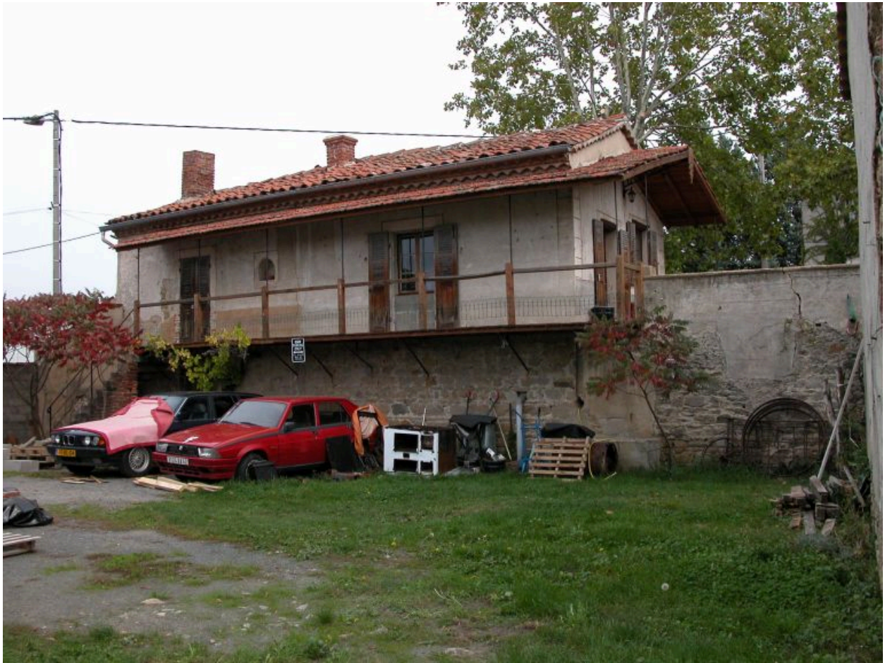
Vue générale du logis depuis la cour.
