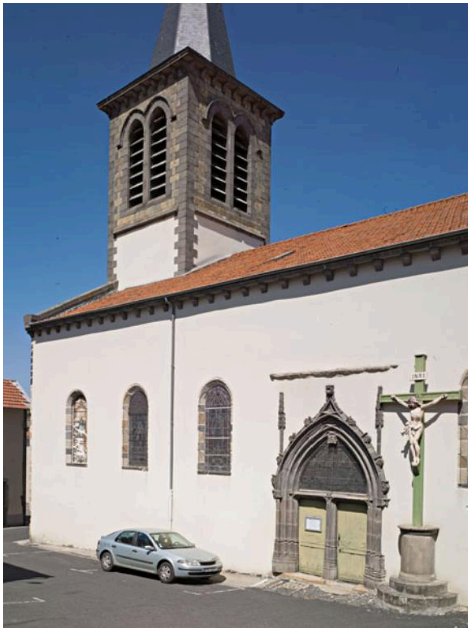
Vue générale de la façade méridionale.
