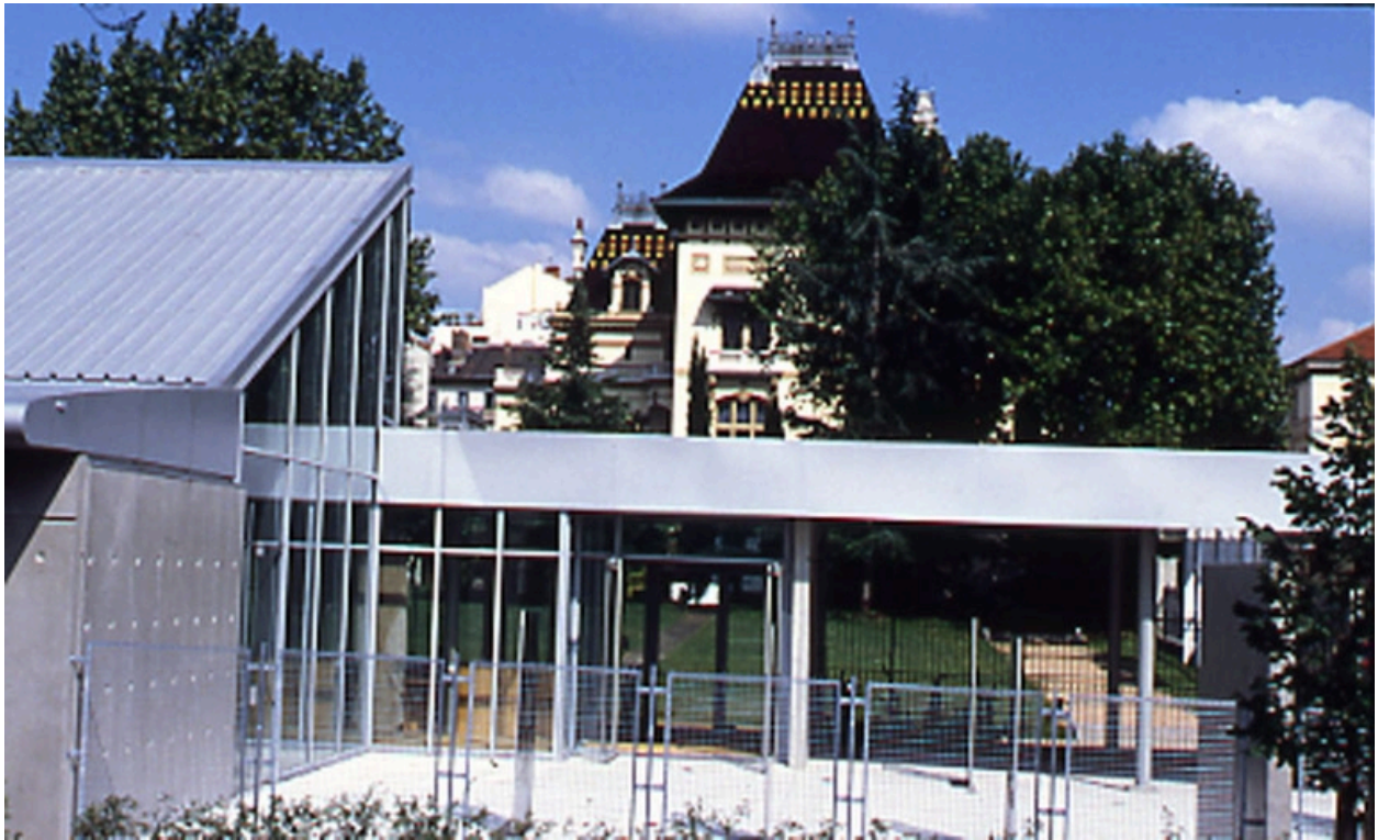
Hangar réhabilité, vue ouest
