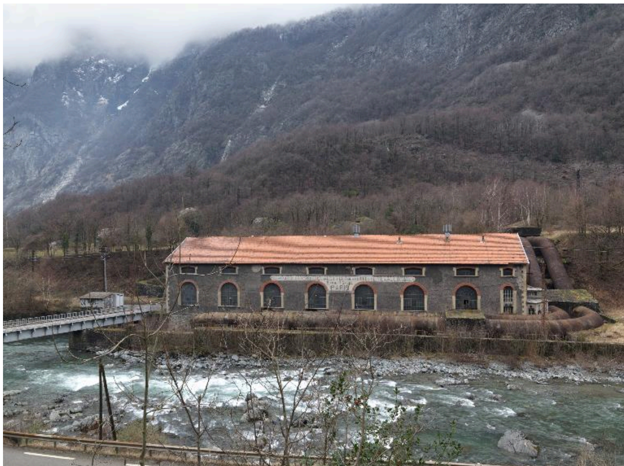
Vue de la centrale des Roberts
