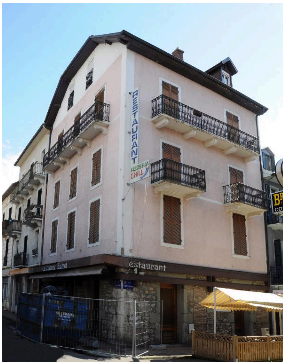
Vue générale depuis la rue de la Dent-du-Chat
