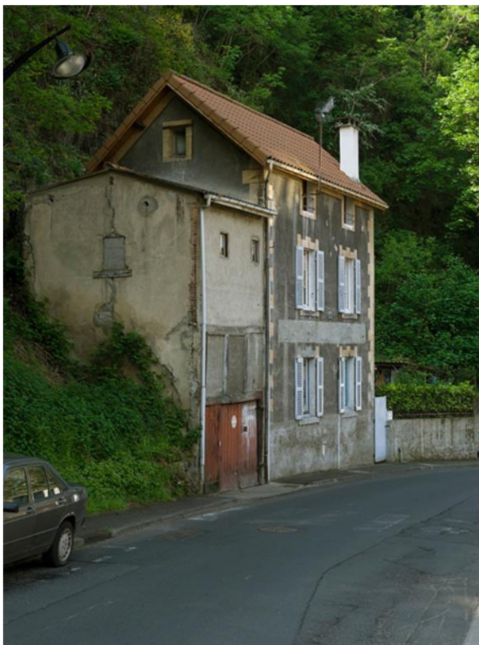
Maison bâtie perpendiculairement à la pente, avenue Joseph-Claussat.
