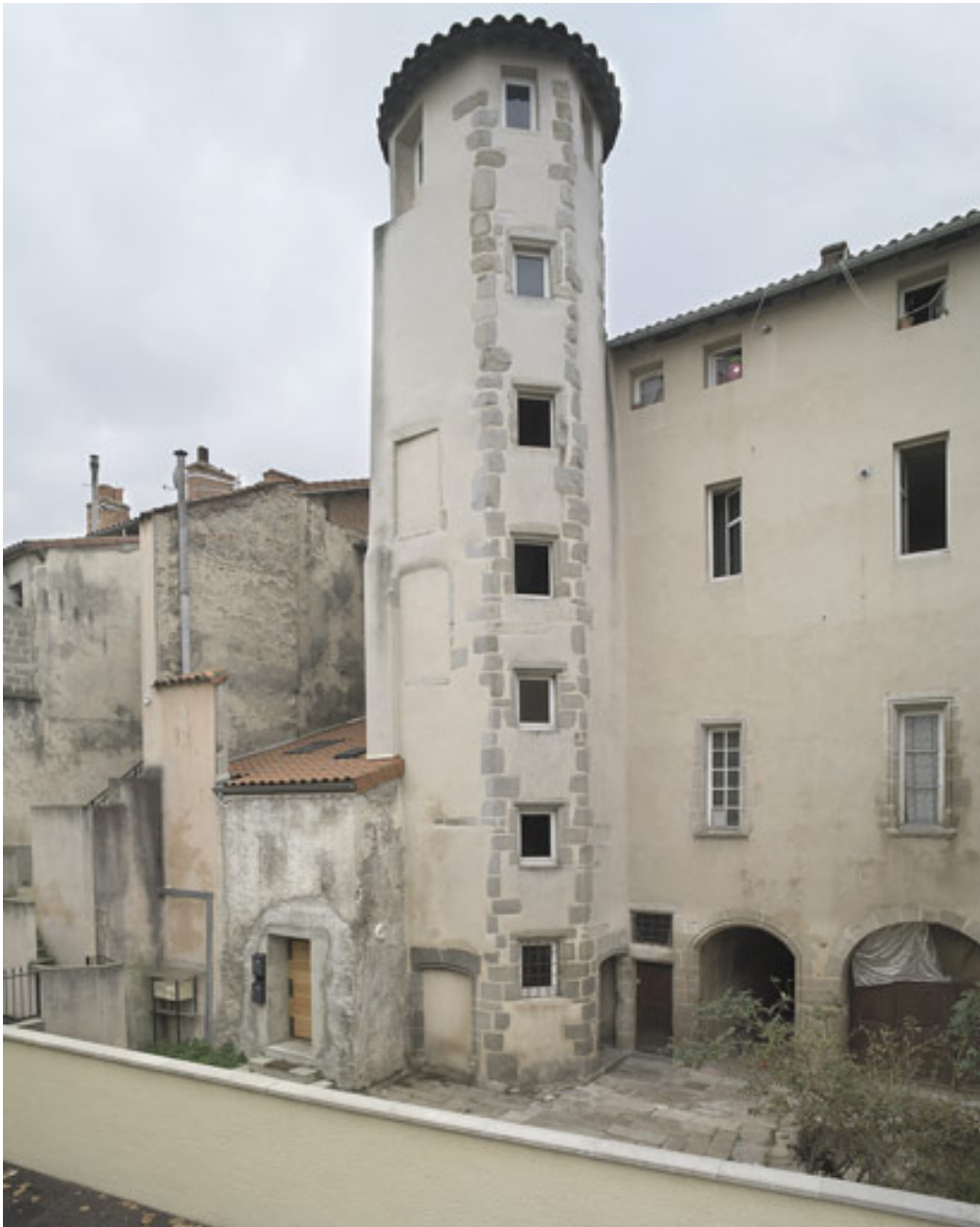
Vue générale sur cour.
