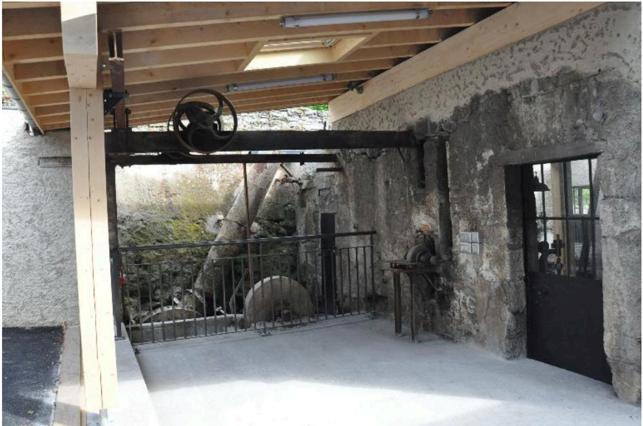
Vue de la forge après les travaux d'aménagement, 2014.
