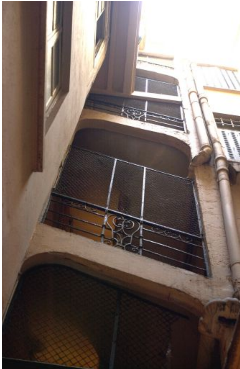
Elévation de la cage d'escalier sur la deuxième cour, partie haute
