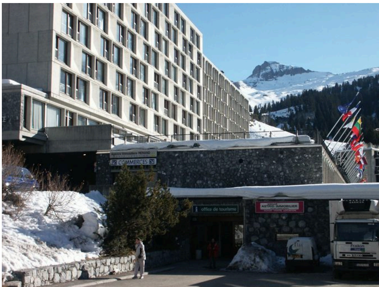
Vue depuis l'ouest
