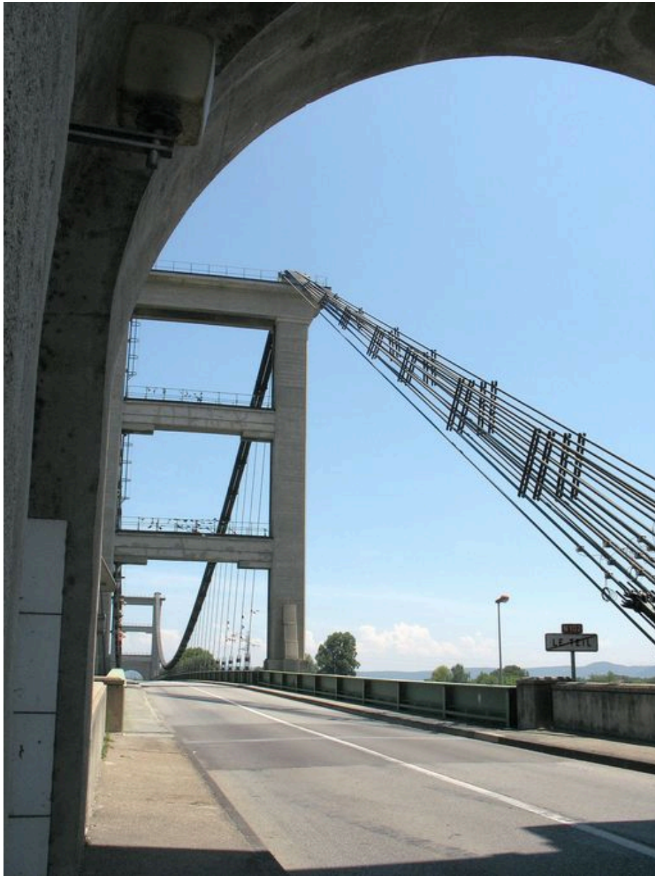
Vue de la chaussée ; pylône de la rive droite (côté Le Teil)
