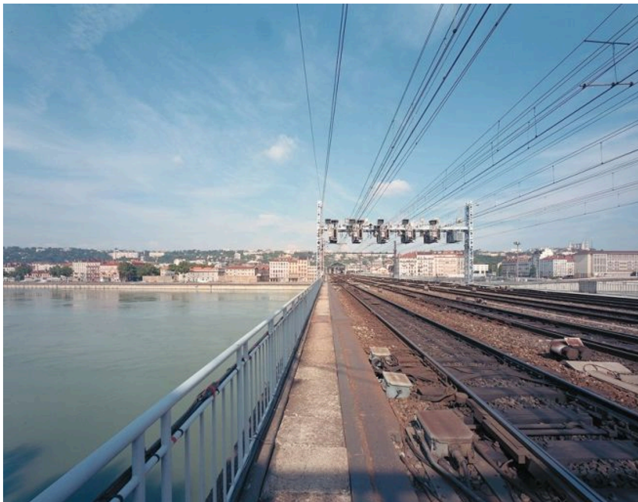
Le pont depuis la rive droite
