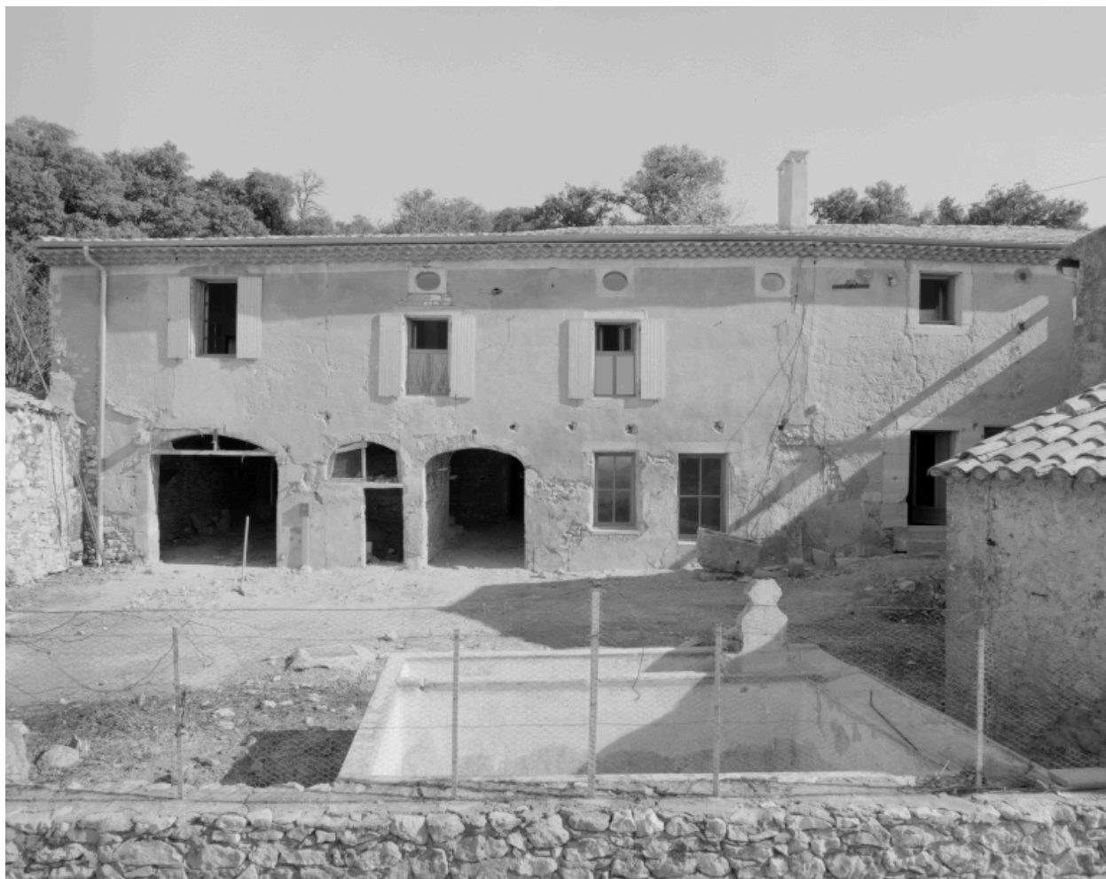
Corps de logis, avec dépendances accolées et lavoir au premier plan.
