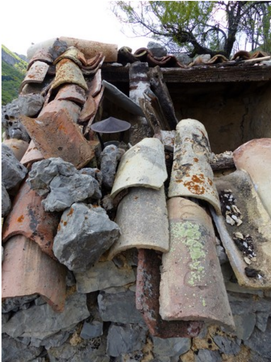
Couverture en tuile creuse, avec une tuile gravée.
