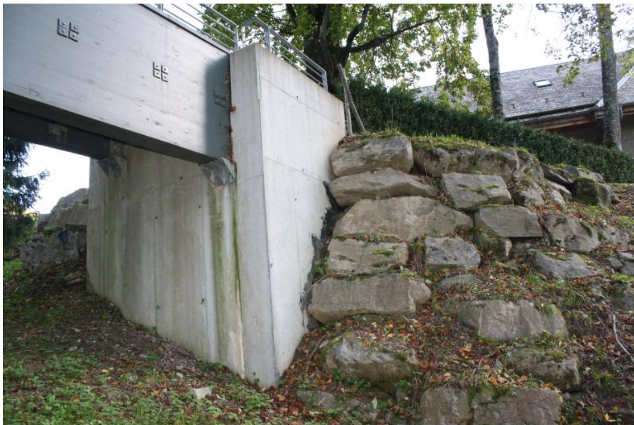
Passerelle de l'Abbaye d'Aulps, détail culée
