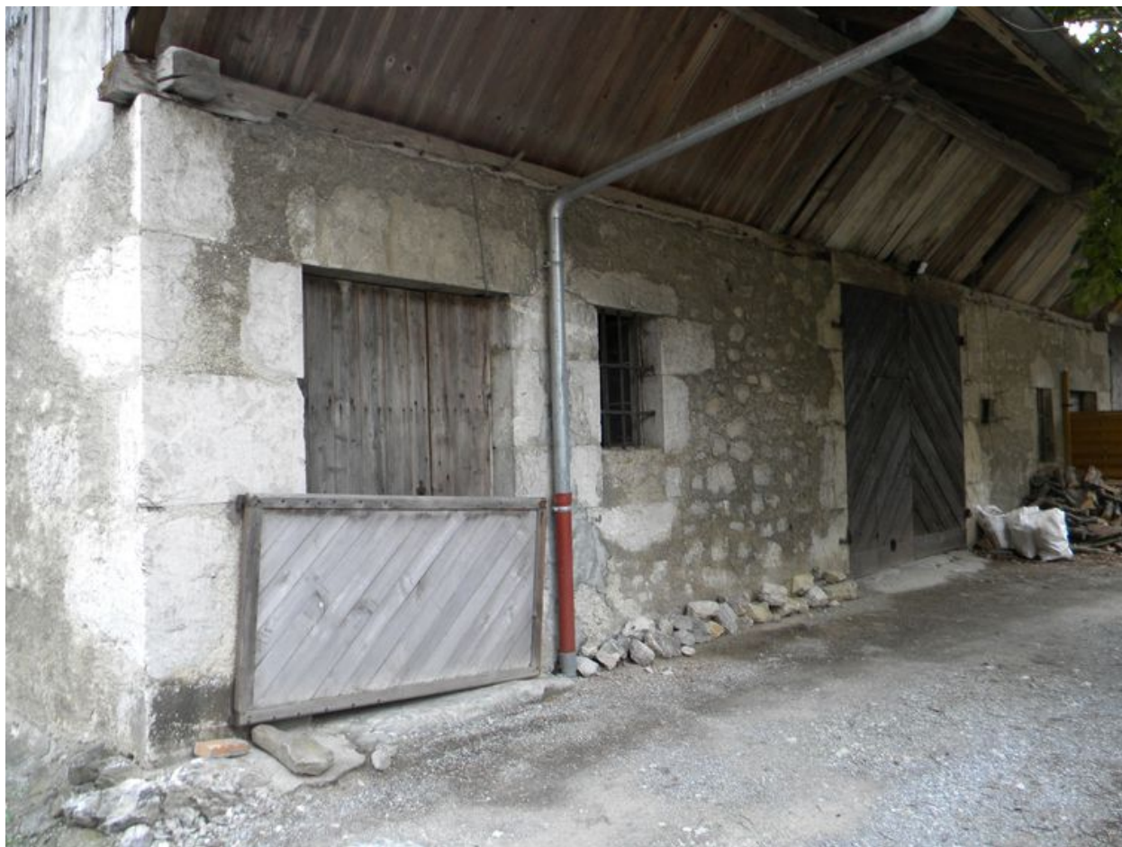
Façade principale de la dépendance agricole sud.
