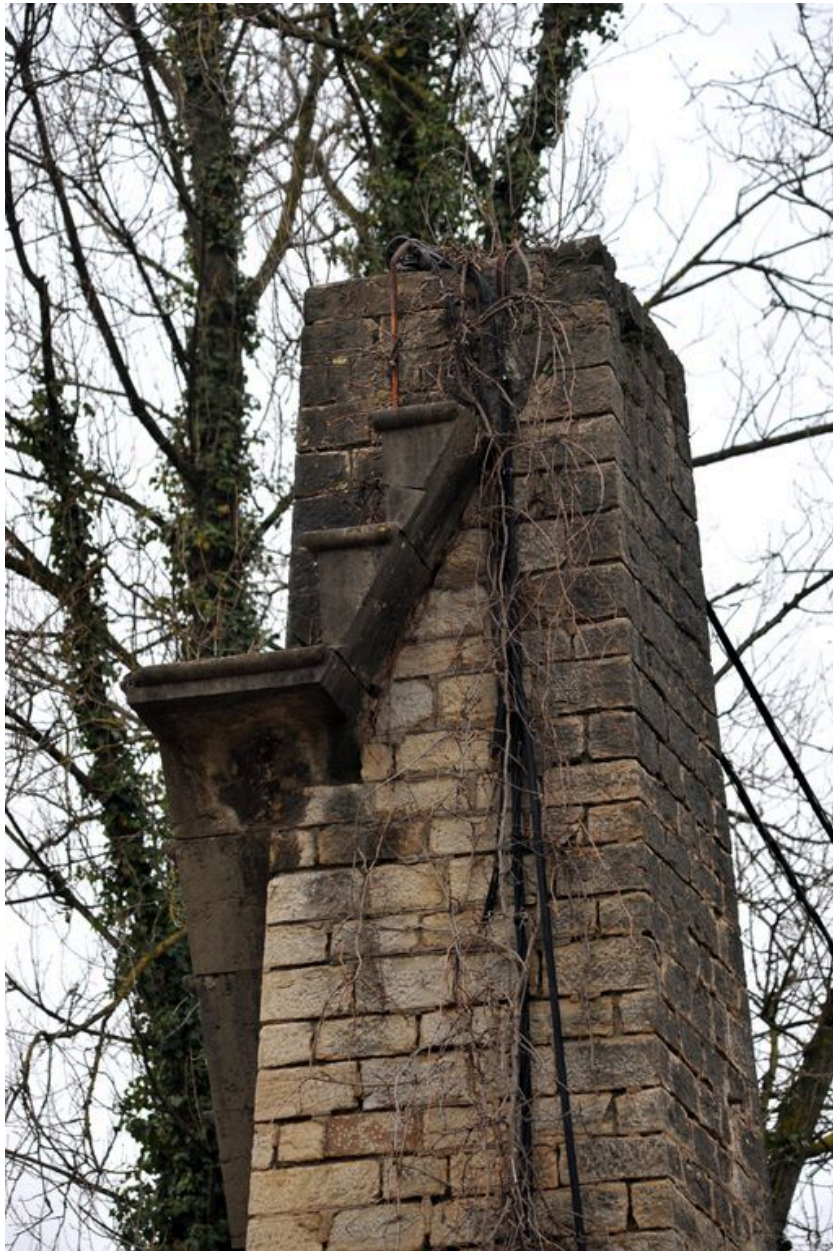
Pile gauche, angle est, vue partielle : sommet (depuis la rive gauche)
