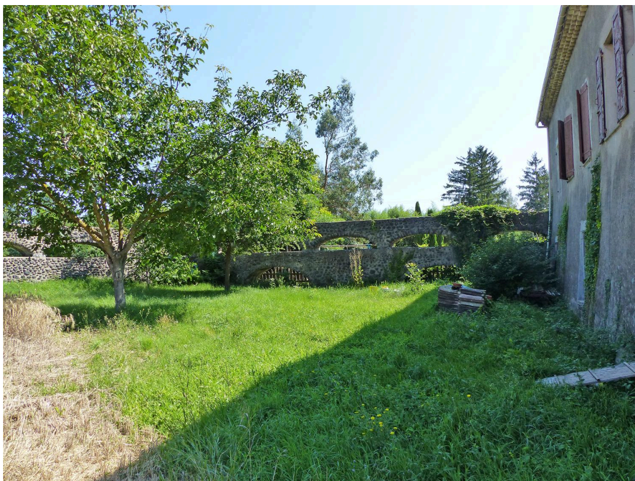
Angle de l'aqueduc avec le moulinage
