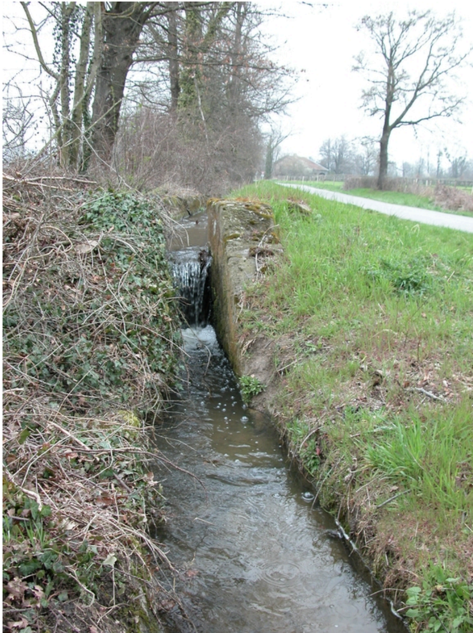
Vue d'une artériole du canal du Forez dérivée de l'artère de Vaugirard, longeant le chemin de Champdieu à Barge.
