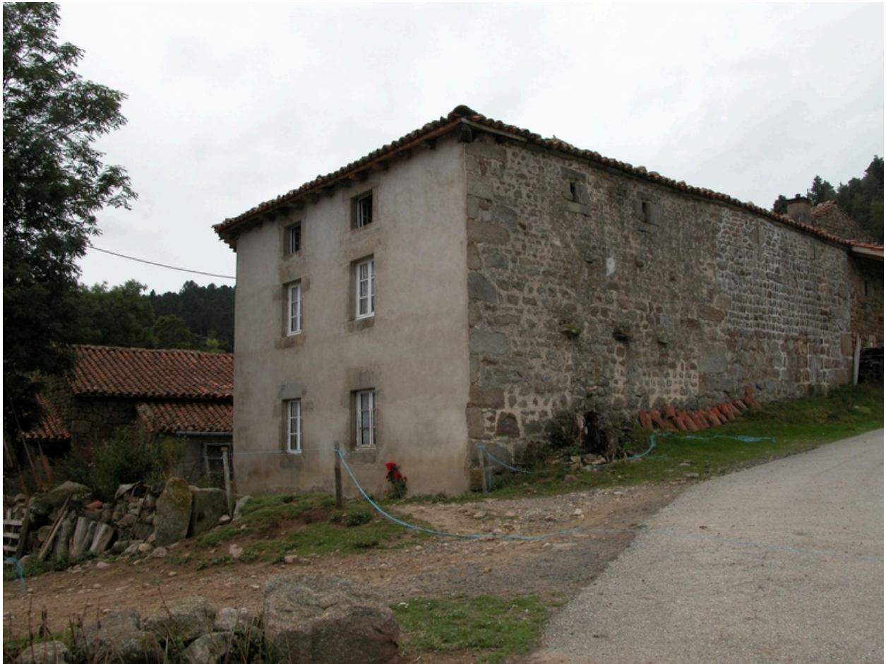
Vue d'ensemble de la ferme depuis le nord-est (mur gouttereau nord du logis).
