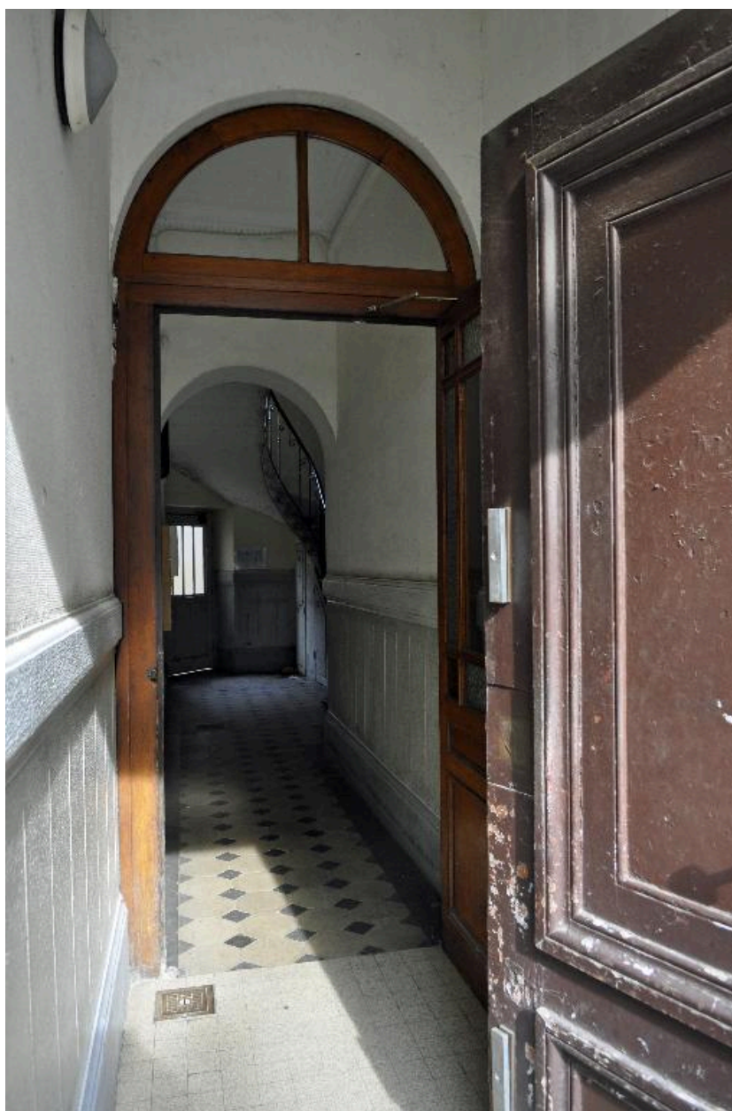
Vue intérieure : le vestibule-sas et l'allée
