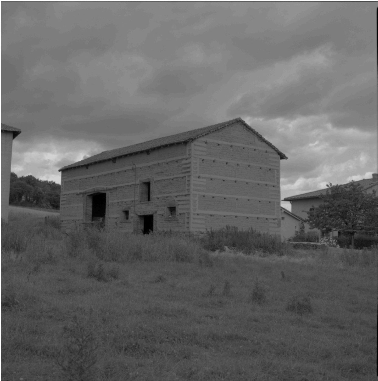
Vue d'ensemble de la grange-étable, de trois-quarts.
