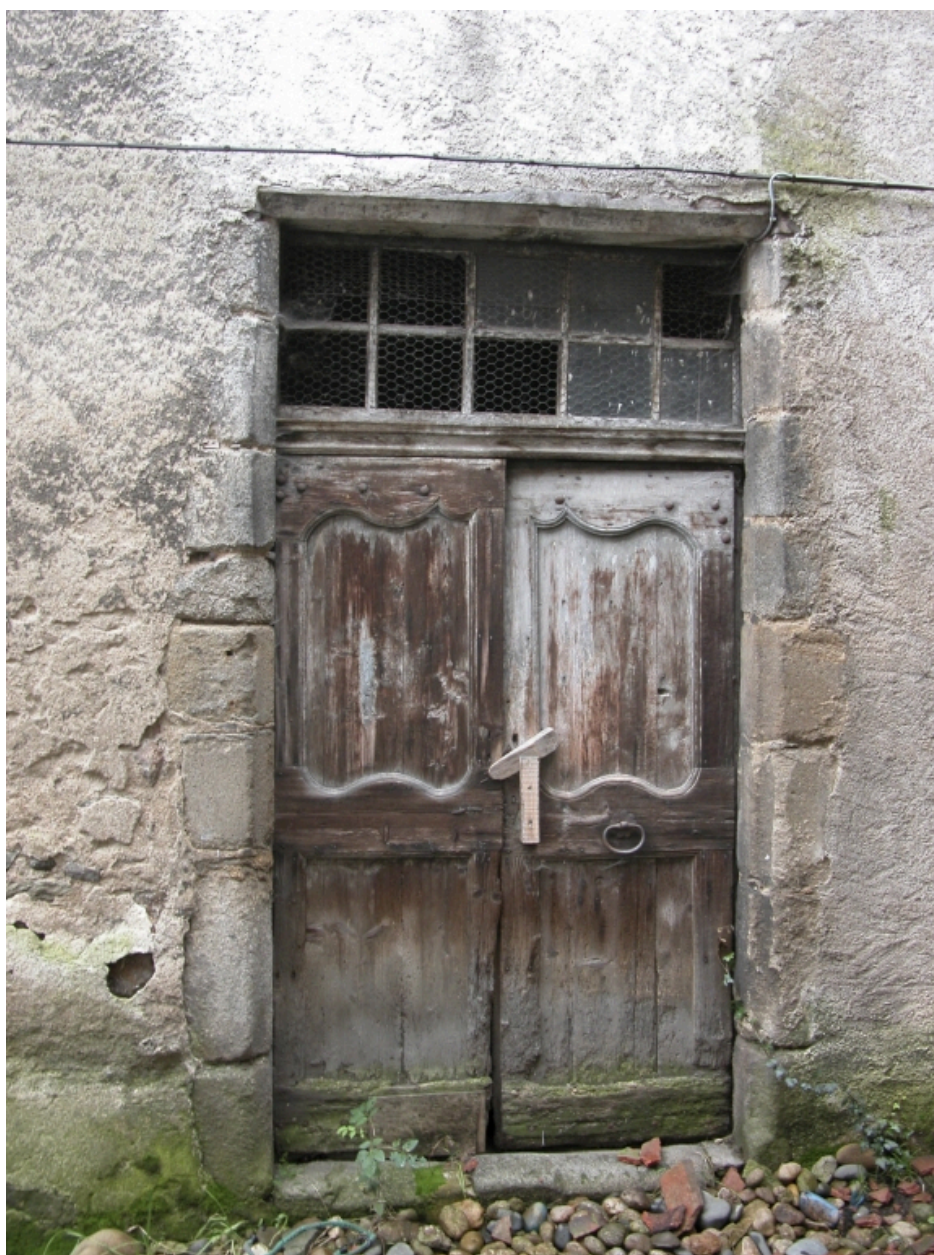
Îlot 2. Roanne (rue de) 11. Vue d'ensemble de la porte sur cour (parcelle 546)
