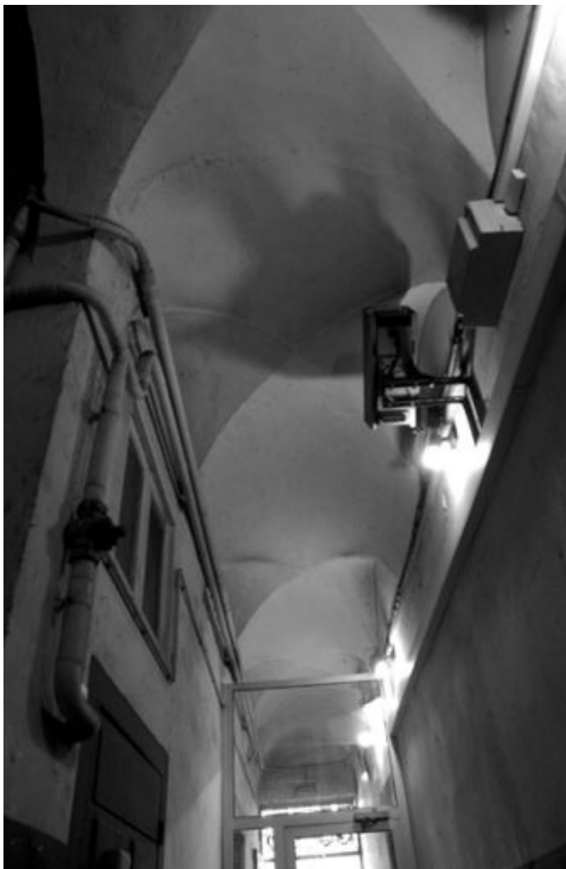
Voûte de l'allée vers la rue Gentil
