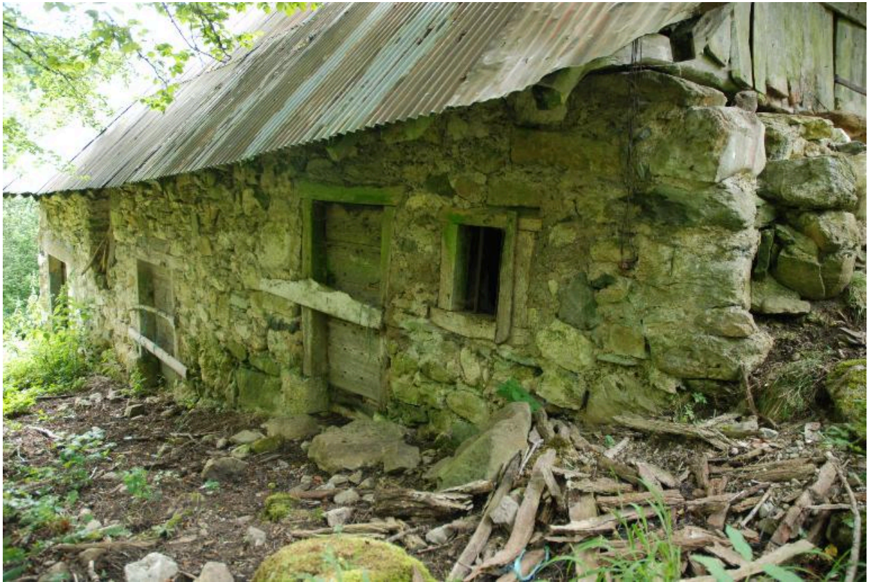
Vue de la façade principale (sud), depuis le sud-est.
