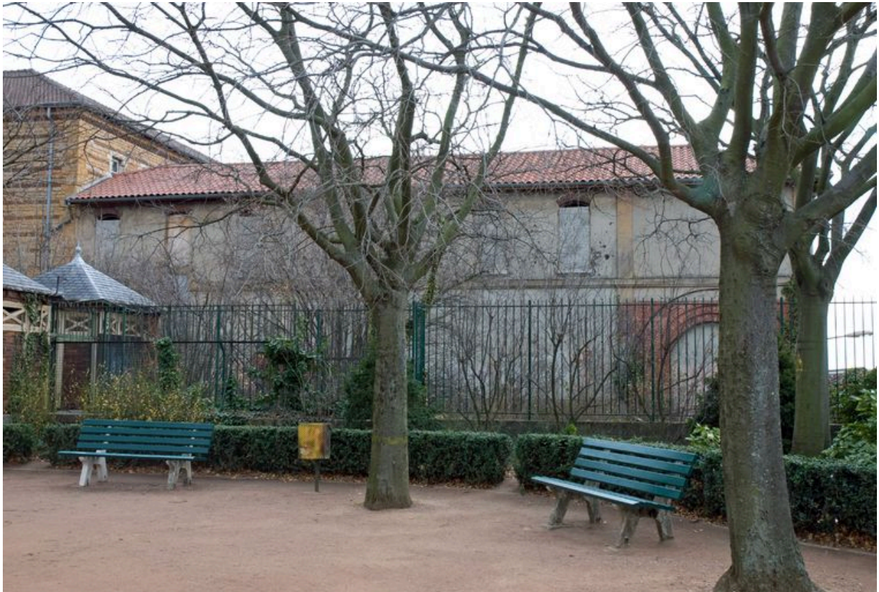
Gymnase, élévation postérieure depuis l'ouest
