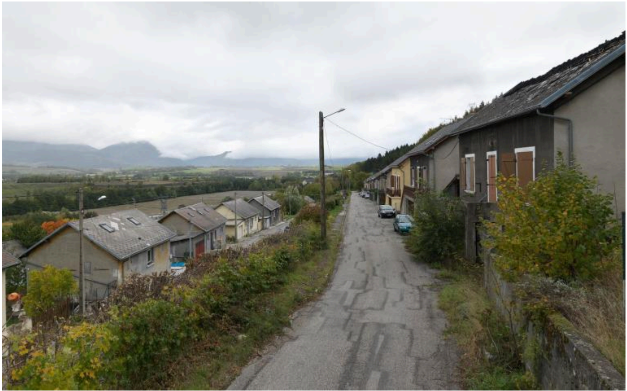
Vue d'ensemble ouest cite la gare du Villaret
