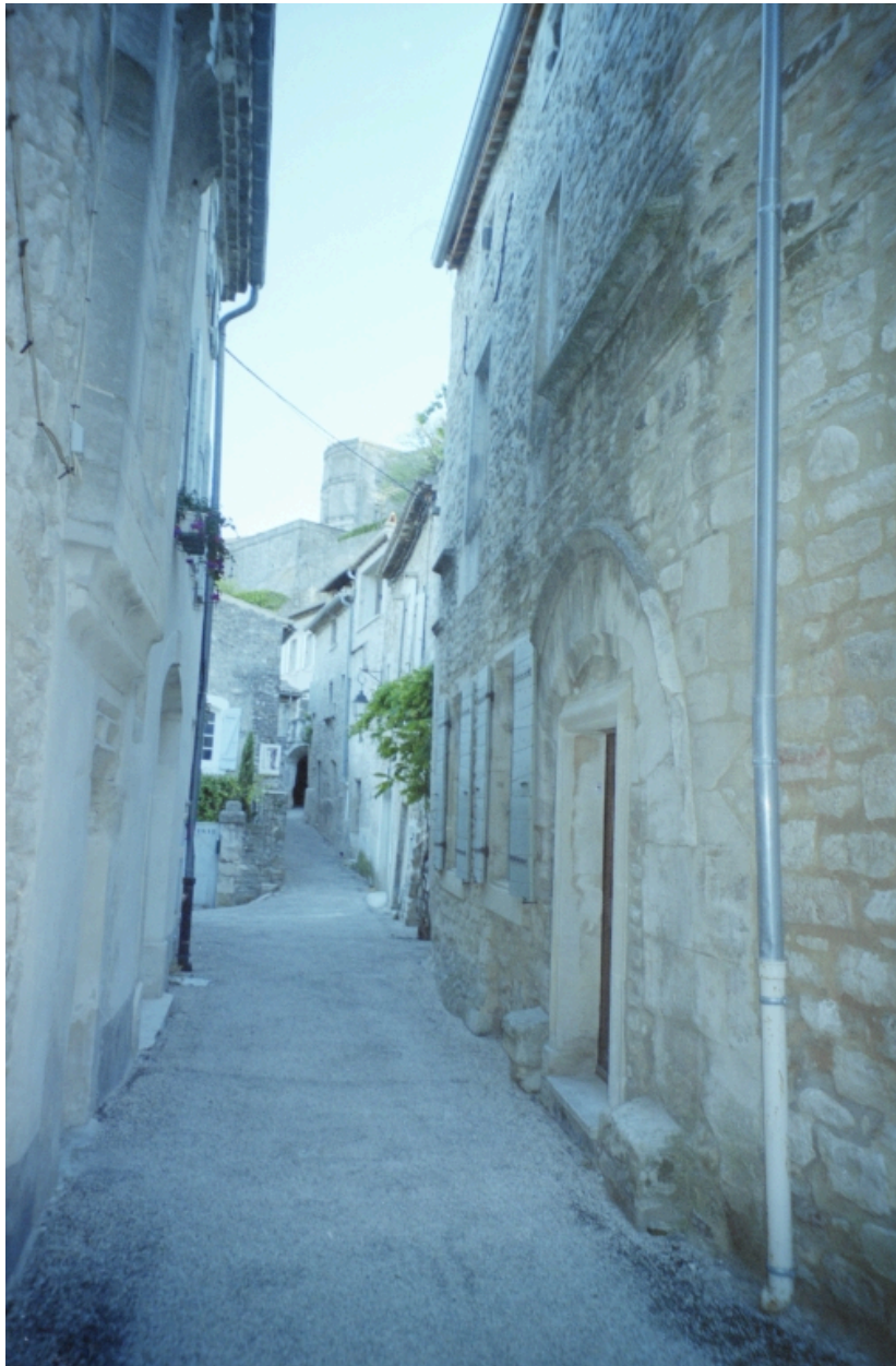
Façade sur rue, vue partielle prise depuis le nord.
