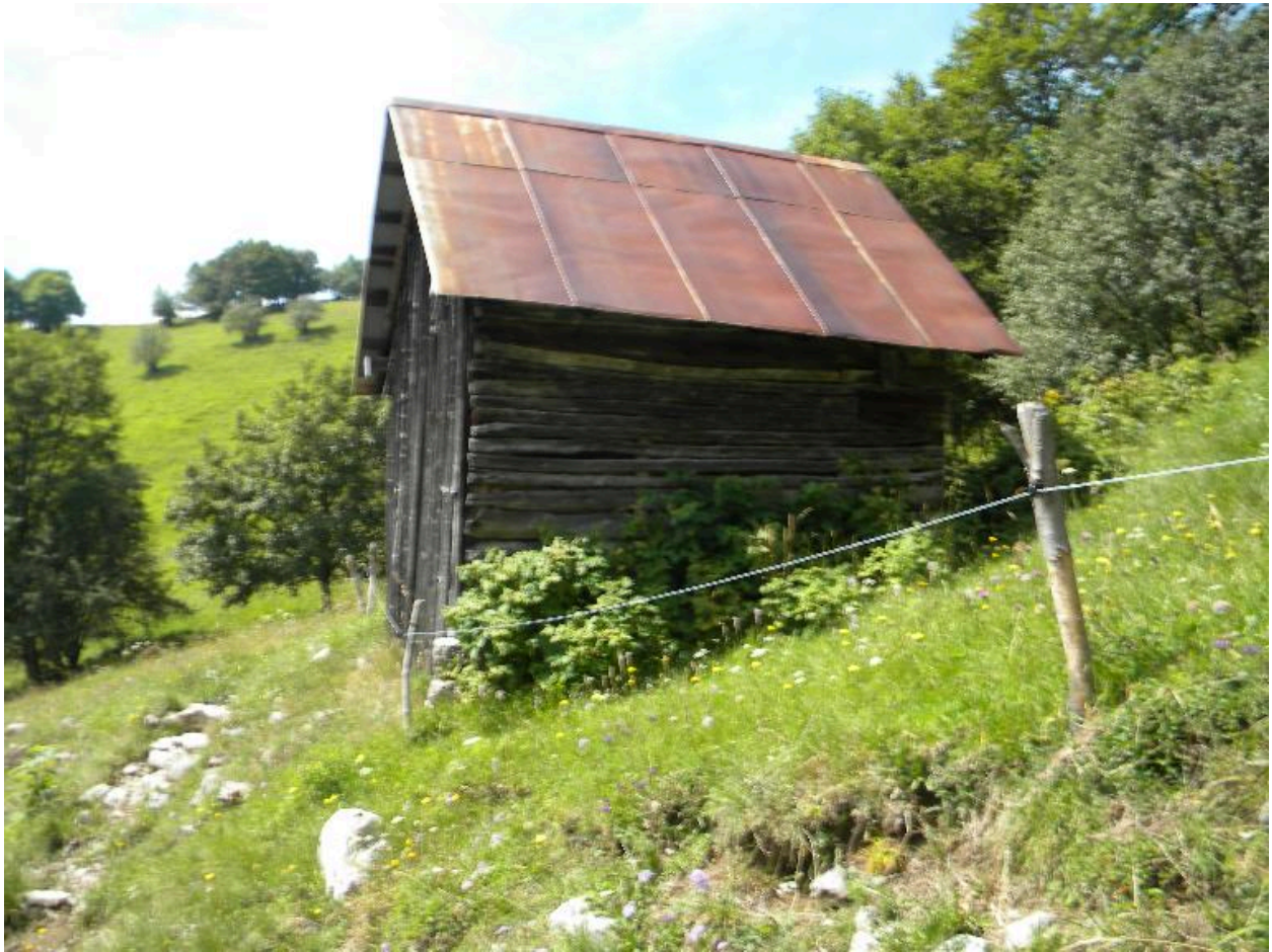
Vue d'une ancienne grange à Très-le-Mont
