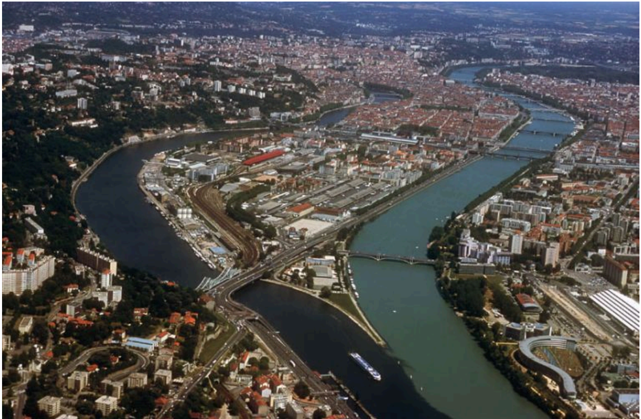
Vue aérienne depuis le sud-sud-ouest
