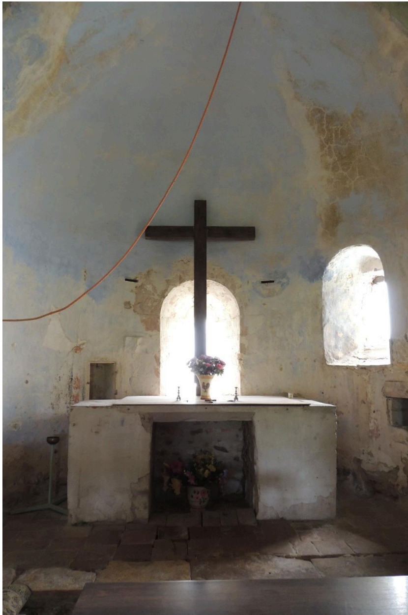
Chœur, maître-autel maçonné, niches murales.
