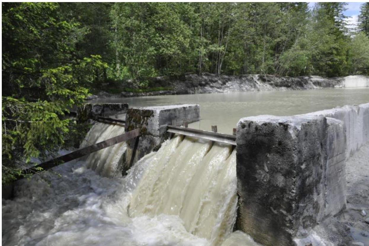
Les trop-pleins aménagés en sortie de bassin
