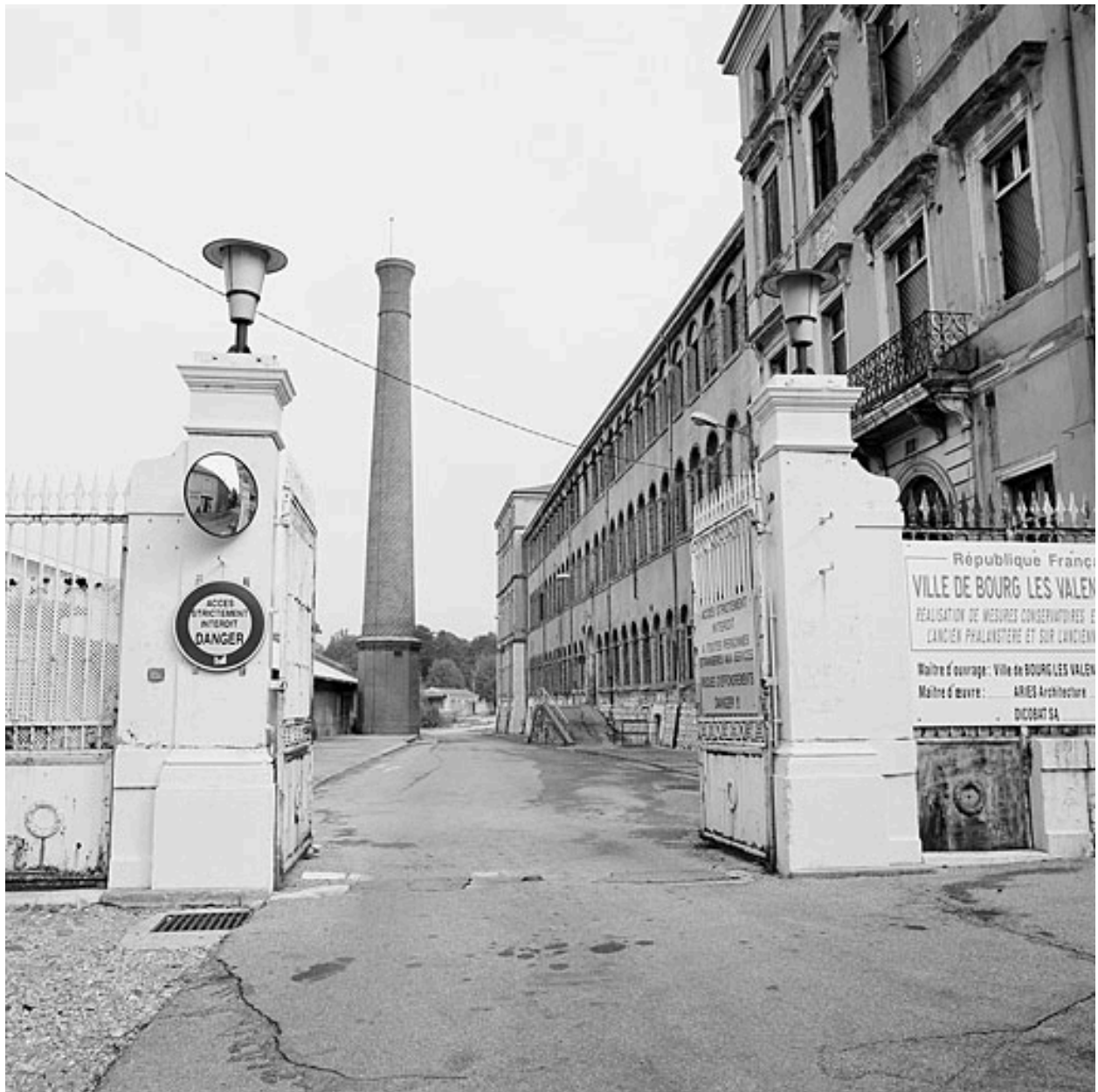
Portail de l'entrée principale
