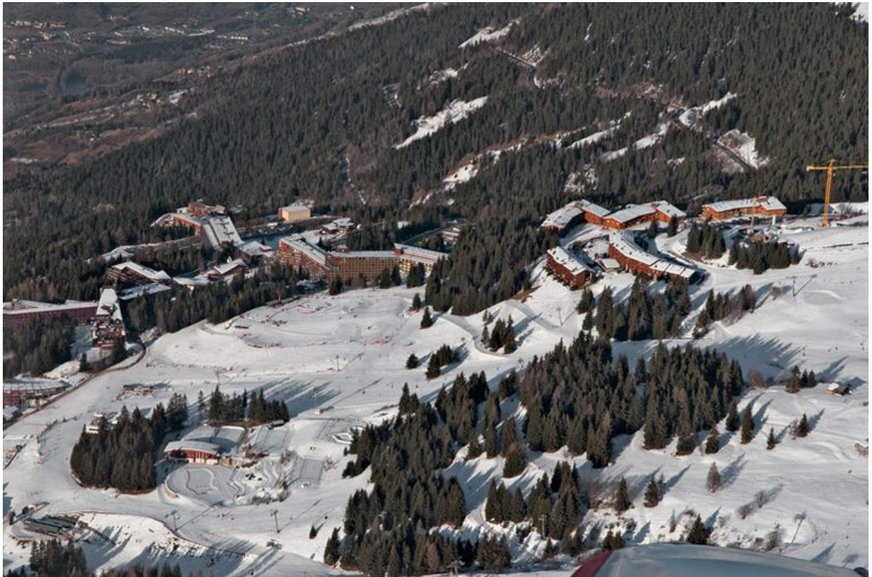
Vue aérienne depuis le sud. La grenouillère
