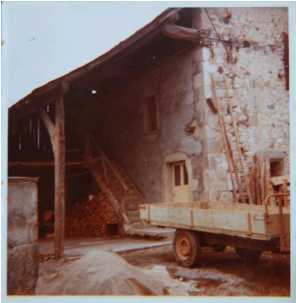
Ferme, puis maison (2016 A6 333, non repérée). Vue depuis le nord-est, avant réfection de la toiture (début des années 1980) (collection particulière).
