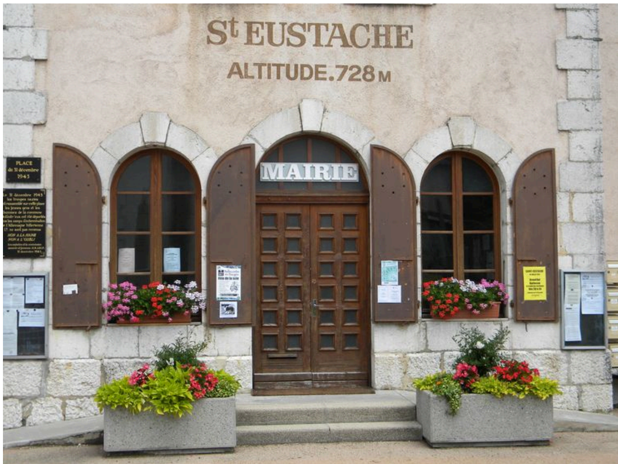
Détail de la façade principale avec l'entrée de la mairie.
