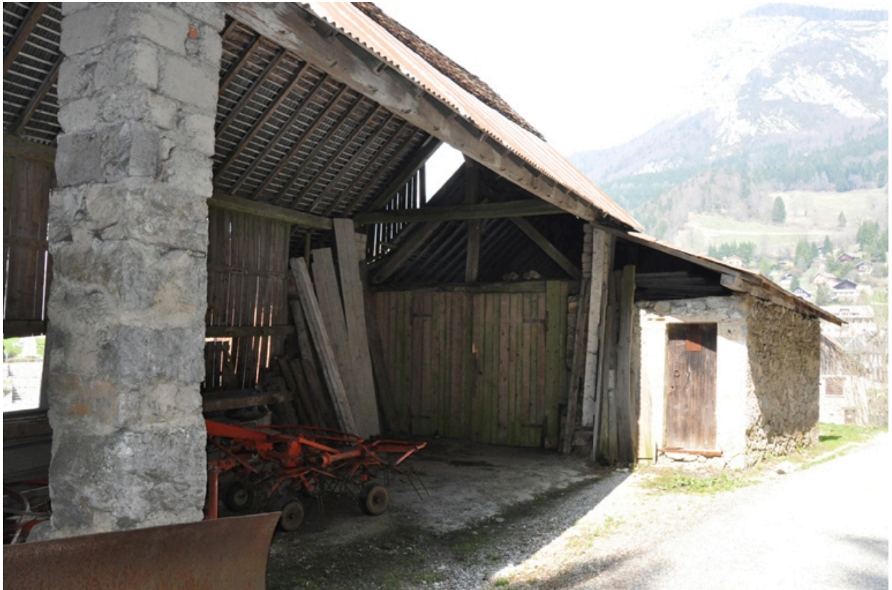
Vue nord-est de la scierie réutilisée en entrepôt agricole
