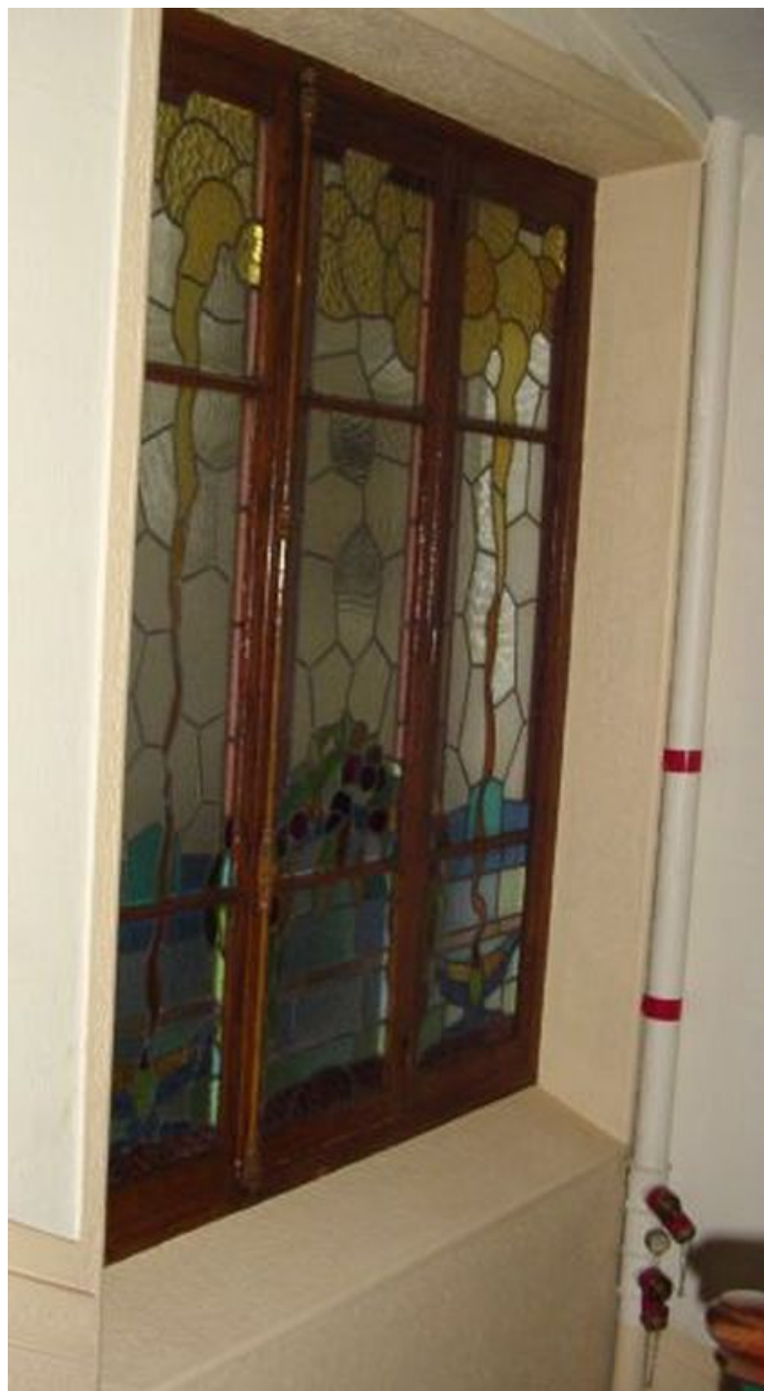
Vitrail éclairant la cage d'escalier
